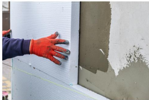
Slika 15. Postavljanje fasade od stiropora (izvor: Canva)
