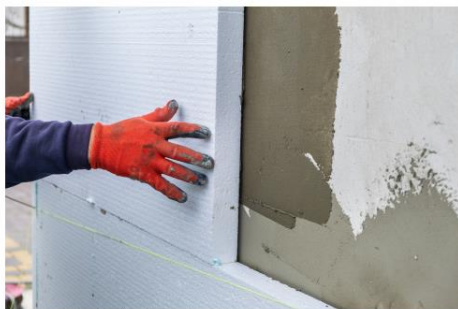
Slika 15. Postavljanje fasade od stiropora (izvor: Canva)
